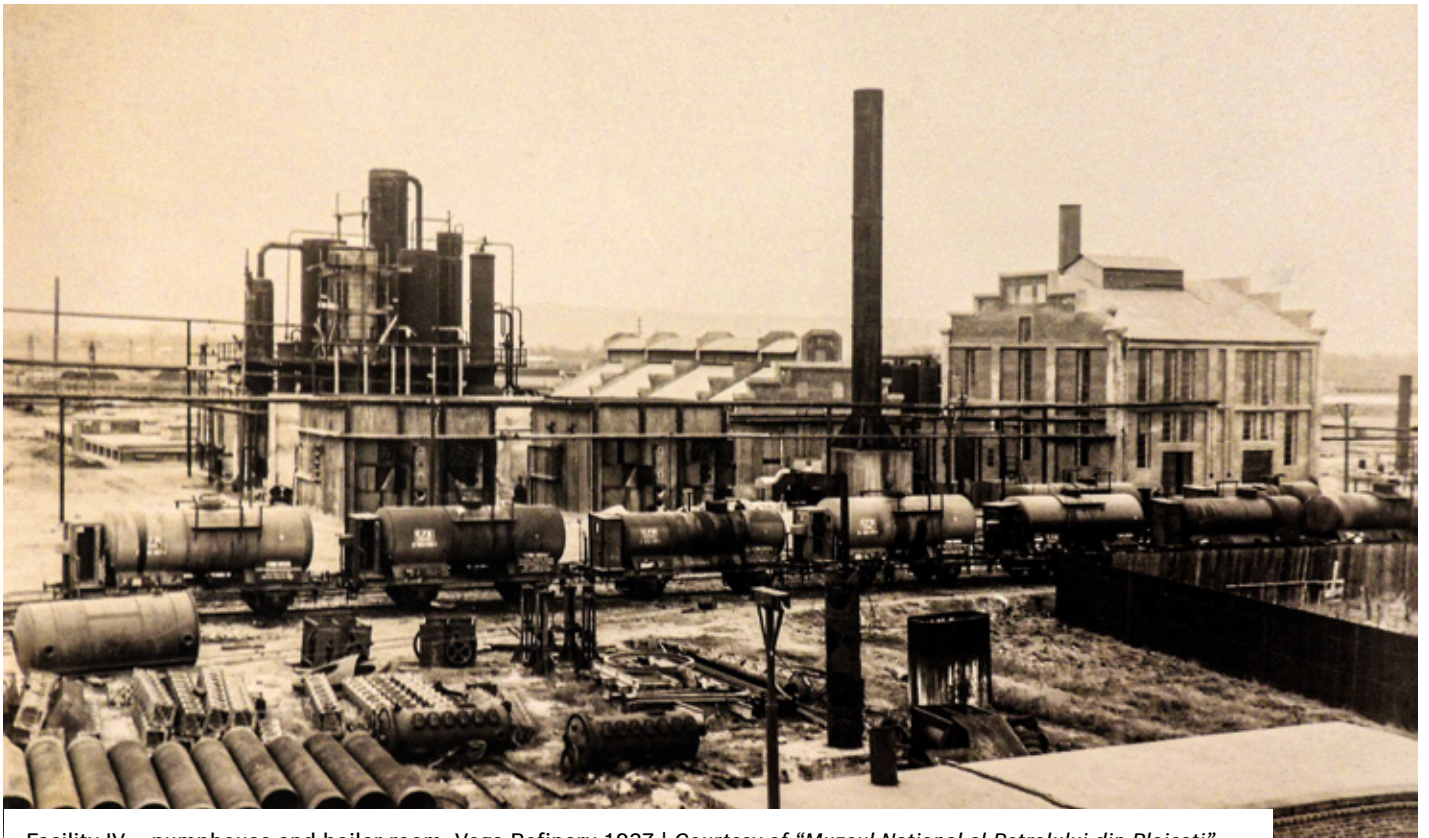
Facility IV – pumphouse and boiler room, Vega Refinery 1937 | Courtesy of “Muzeul Național al Petrolului din Ploiești”
